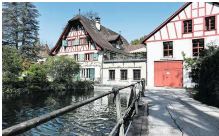
Das Wasserkraftwerk Hammer. Bild: Stefan Kaiser (Cham, 21. April 2017)
